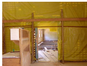
Obras de Restauração do antigo Palácio
