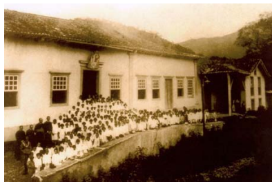
O edifício teve usos diversos ao longo do século XX. No tempo desta fotografia (meados daquele século) nele funcionava o Ginásio Estadual Dom Silvério.
