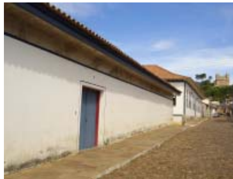
Entrada da Biblioteca Arquiepiscopal, tendo ao fundo a Igreja de São Pedro dos Clérigos
