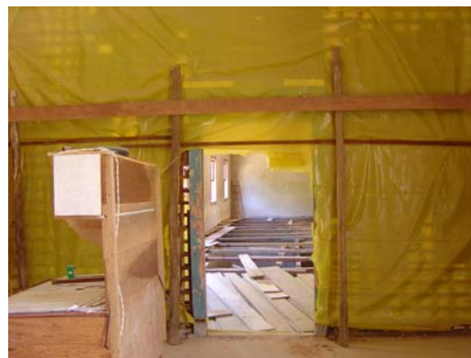
Obras de Restauração do antigo Palácio
